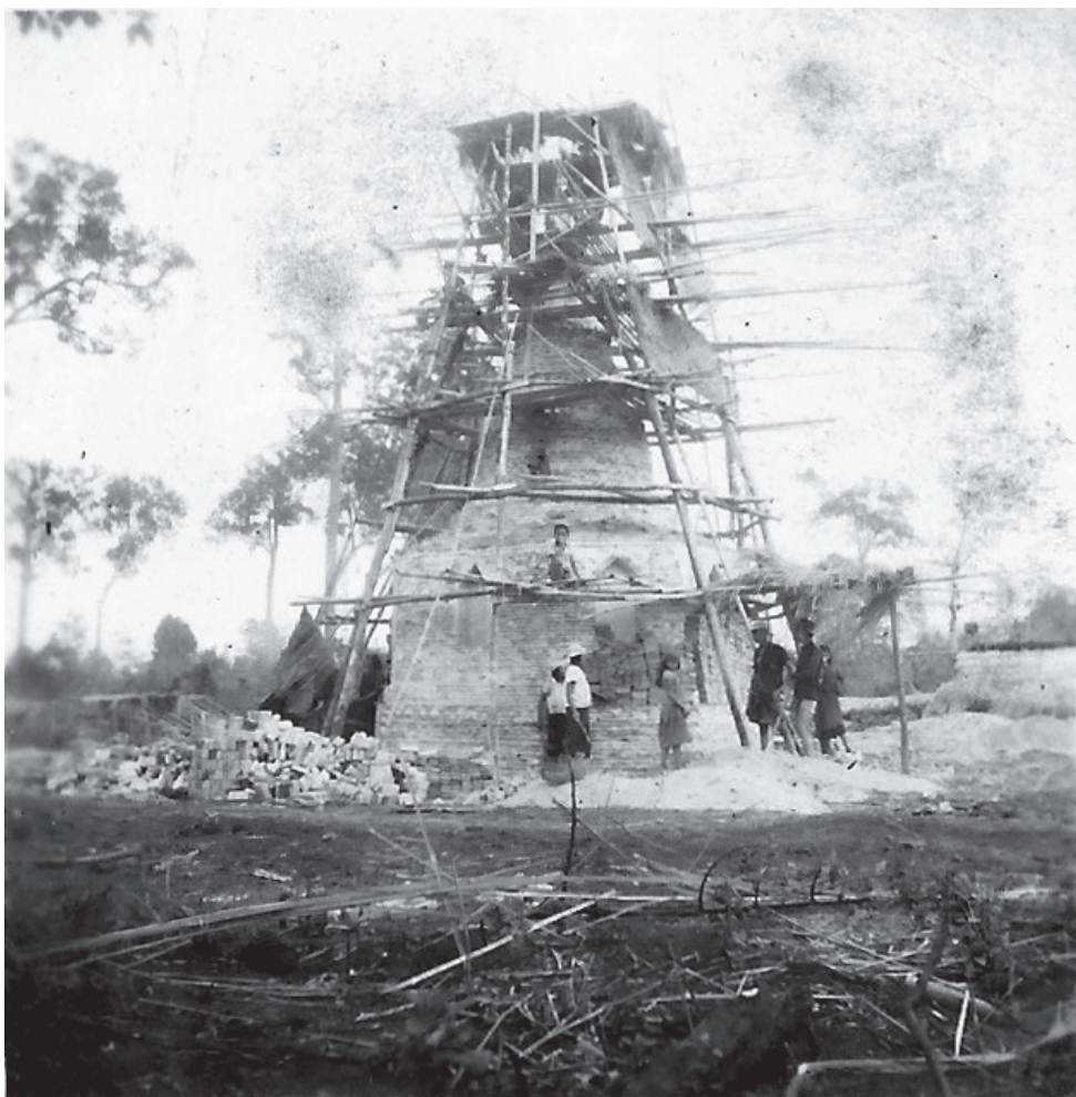
พระธาตุเจดีย์เวียงชัยขณะทำการก่อสร้าง
